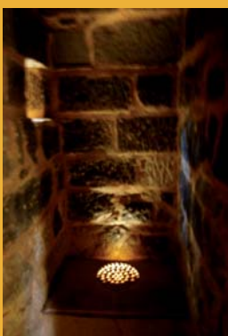
intérieur de la latrine
