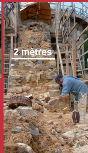
mur de courtine Est
