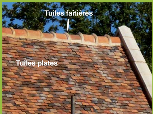
Tuiles plates et tuiles faîtières posées sur un toit
