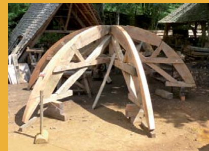
Les charpentiers ont réalisé le cintre en bois qui va soutenir les maçonneries de la voûte durant sa construction.
