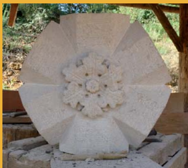
La clef de voûte a été taillée avec des feuilles de chêne sculptées en son centre.
